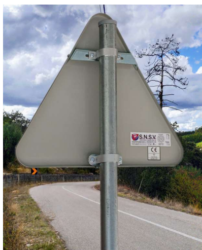
FIXAÇÃO NA ABA
