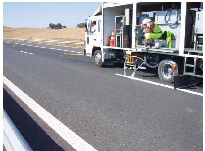
Aplicação de pintura ecológica de base aquosa
