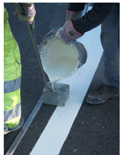
Aplicação de pintura ecológica de base aquosa
