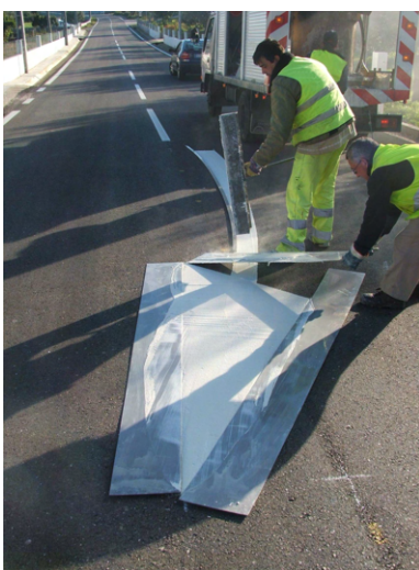
Aplicação de pintura a dois componentes a frio
